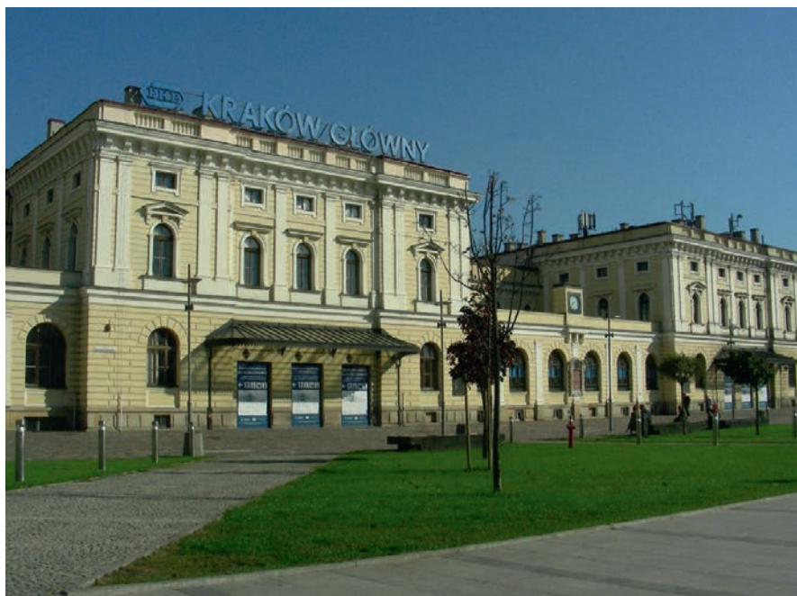
Fot. 2. Budynek dawnego dworca kolejowego Kraków Główny (fot. J. Kukulak)
