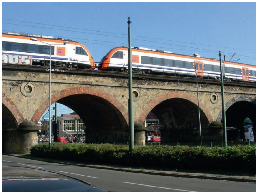
Fot. 3. Kraków – wiadukt kolejowy przy ul. Grzegórzeckiej, dawny most nad starym korytem Wisły (fot. J. Kukulak)
