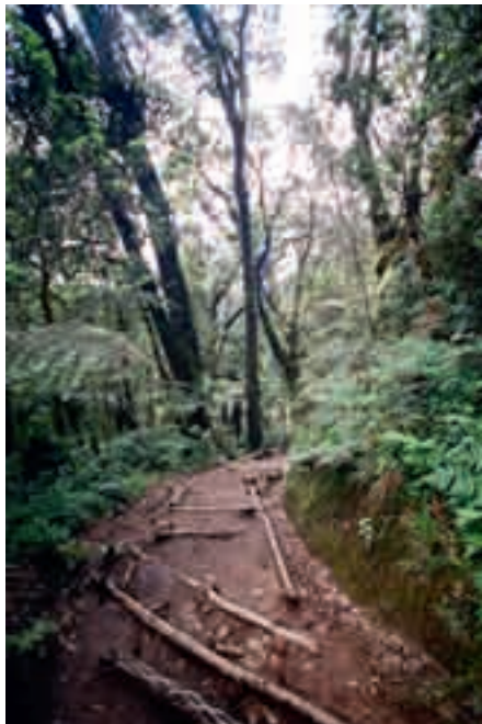
Fot. 4. Odprowadzające wodę progi, trasa Machame (fot. M. Apollo)
