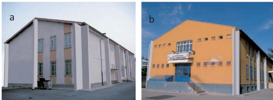
Rys. 6. Przykładowe wzmocnienia szkół żelbetonowymi tarczami ściennymi [12]
