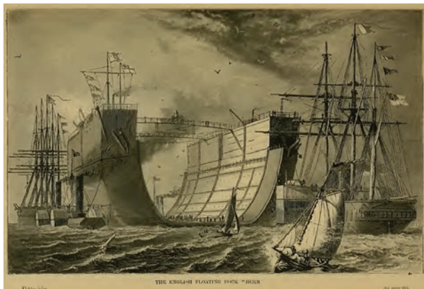
Ryc. 18. Angielski dok pływający „Bermuda” (E.H. Knight, Knight’s American Mechanical Dictionary. Being a description of tools, instruments, machines, processes, and engineering , vol. 2, New York 1875, s. 884, płyta XIX) pozyskiwano ze wspomnianych wyżej tygodników o treści ogólnej,
