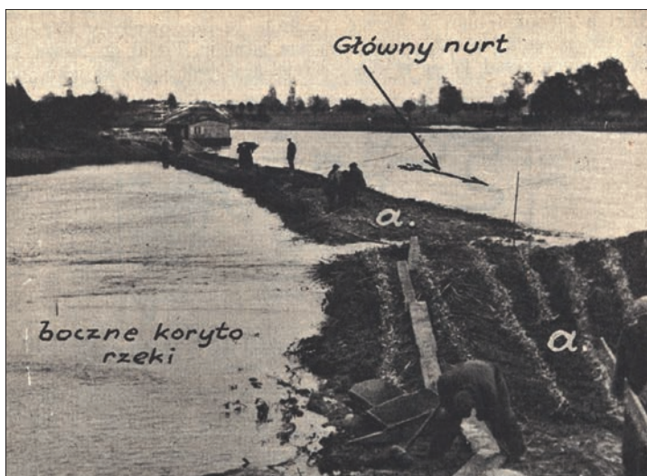
Ryc. 112. Budowa tamy. „Przyroda i Technika” 1938, z. 4, s. 222
