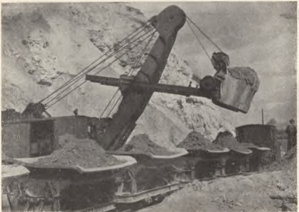
Fig. 8. Zdejmowanie 20-metrowego nadkładu kamieniołomu w Miękinia.
