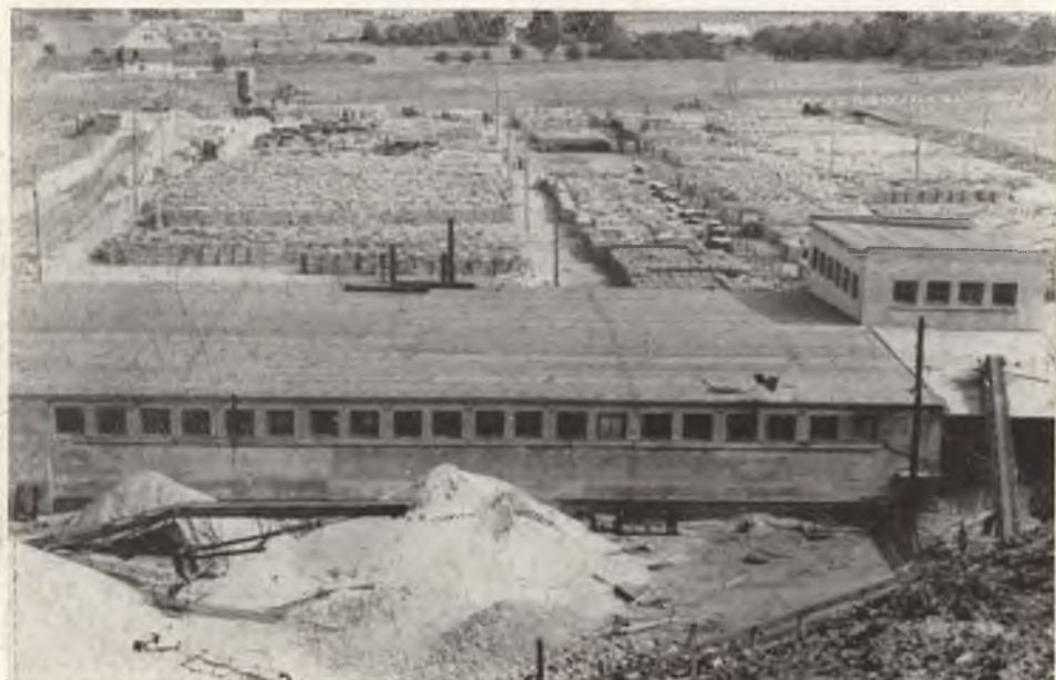
Fig. 4. Nowoczesna betoniarnia w Jaworznie
