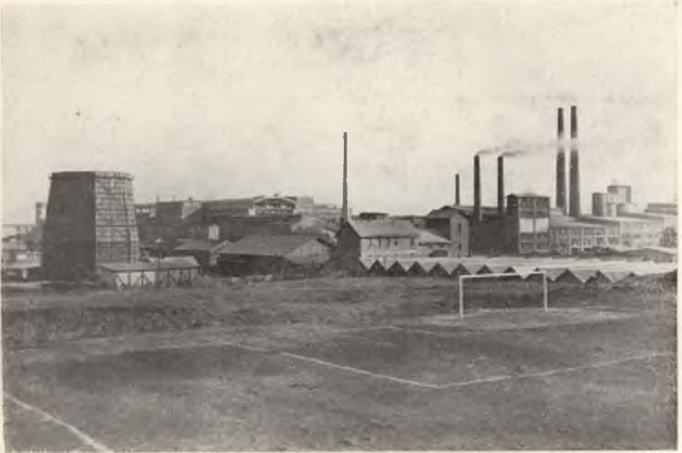
Fig. 7. Krajobraz przemysłowy okolic Sierszy. Na pierwszym planie fabryka eternitu i cementownia. W głębi huta tlenków glinu. Fot. L. Pakuła
