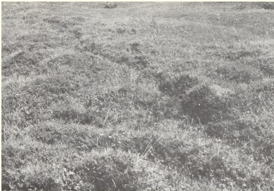
Fot. 5. SZCZELINA W STREFIE KLINA LODU GRUNTOWEGO (fot. K. Pękała)
