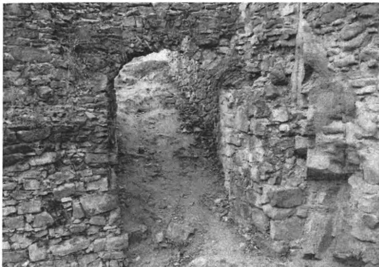
Ryc. 2. Wieża – szyja schodów (widok od wnętrza pomieszczenia)
