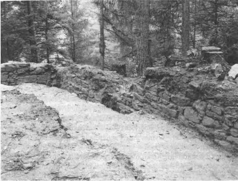
Ryc. 4. Fragment zachodniego budynku mieszkalnego (widok od północy)
