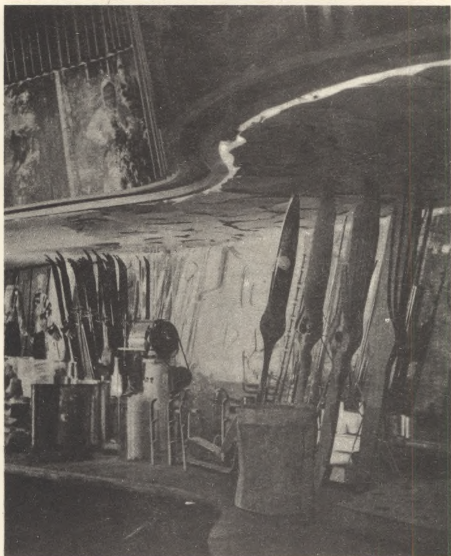
Fot. 6. Pawilon Fiński, fragment ściany falistej - architekt A. Aalto
