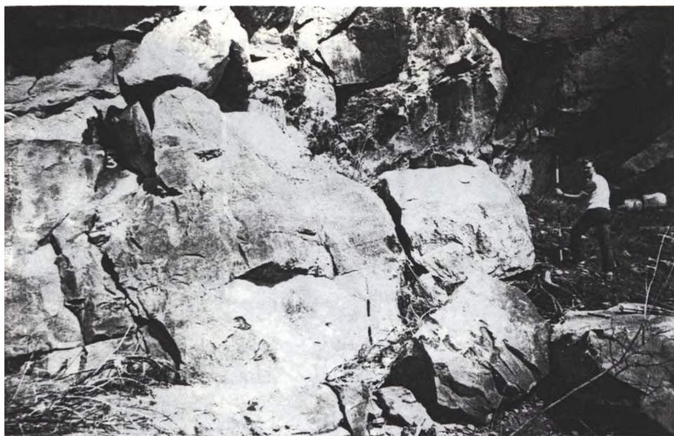
Fot. 7. Naruszenie równowagi przez abrazję spowodowało przesunięcie dużych pakietów skalnych
