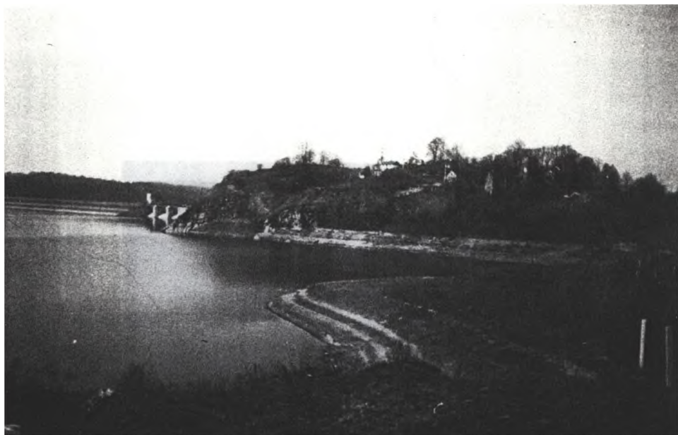
Fot. 1. Terasy abrazyjne związane z wahaniami stanów wód w zbiorniku; na dalszym planie stoki Zamkowej Góry przekształcone przez głębokie osuwiska skalne
