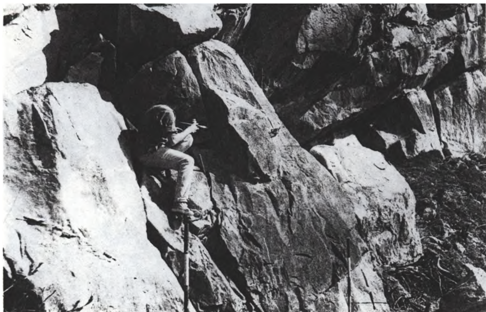
Fot. 8. Intensywnie spękane pakiety skalne w obrębie dolnej części głębokiego osuwiska skalnego
