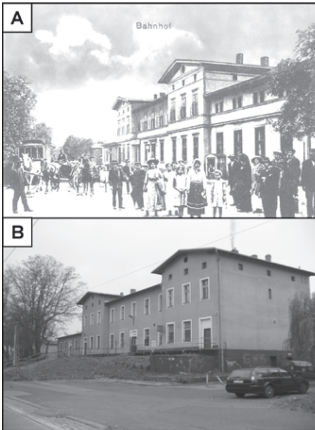
Fot. 2. Dworzec kolejowy na początku XX w. (A) oraz w 2013 r. (B)
